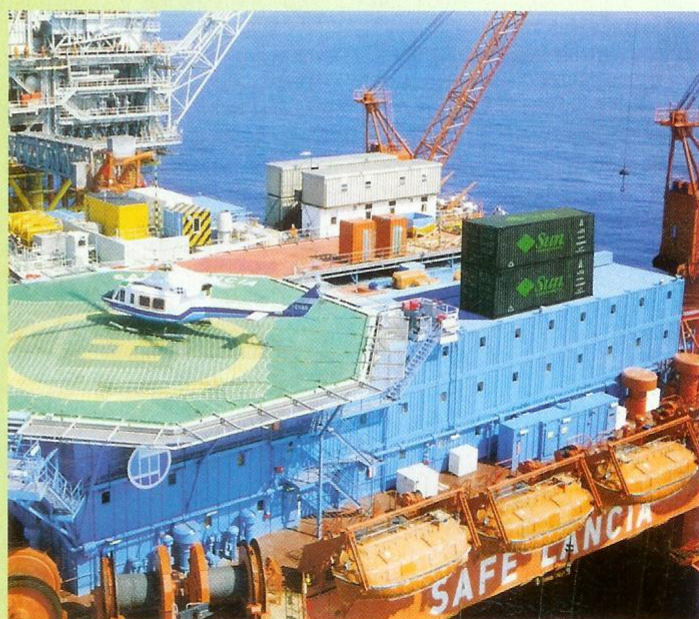
Mostoha körülmények között is gyorsan üzembe helyezhető a Sun Modular Data Center
