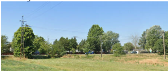
A tervezési területen található légvezetékek (Google Street View 2024)
